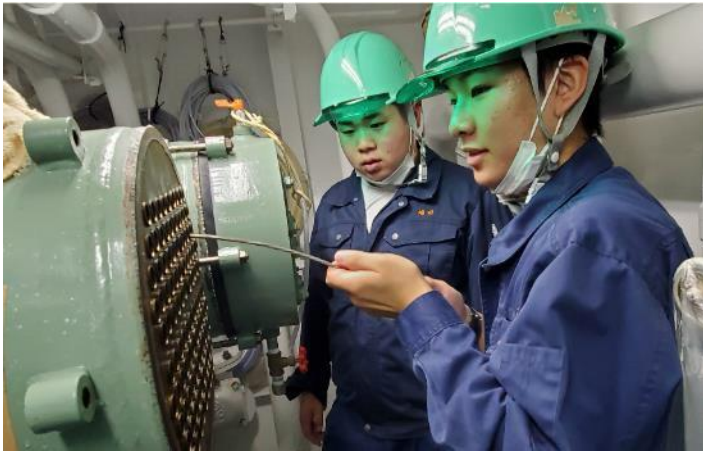
機関科実習の様子（14 日 出港前）
