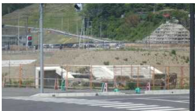
かさ上げ工事をされ駐車場として使用 (未完成)
