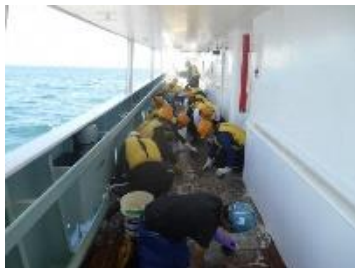
9/17 デッキのヤシズリ作業
